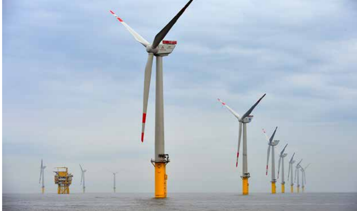
Die Windkraftanlagen vor Borkum speisen jetzt Strom ein.
