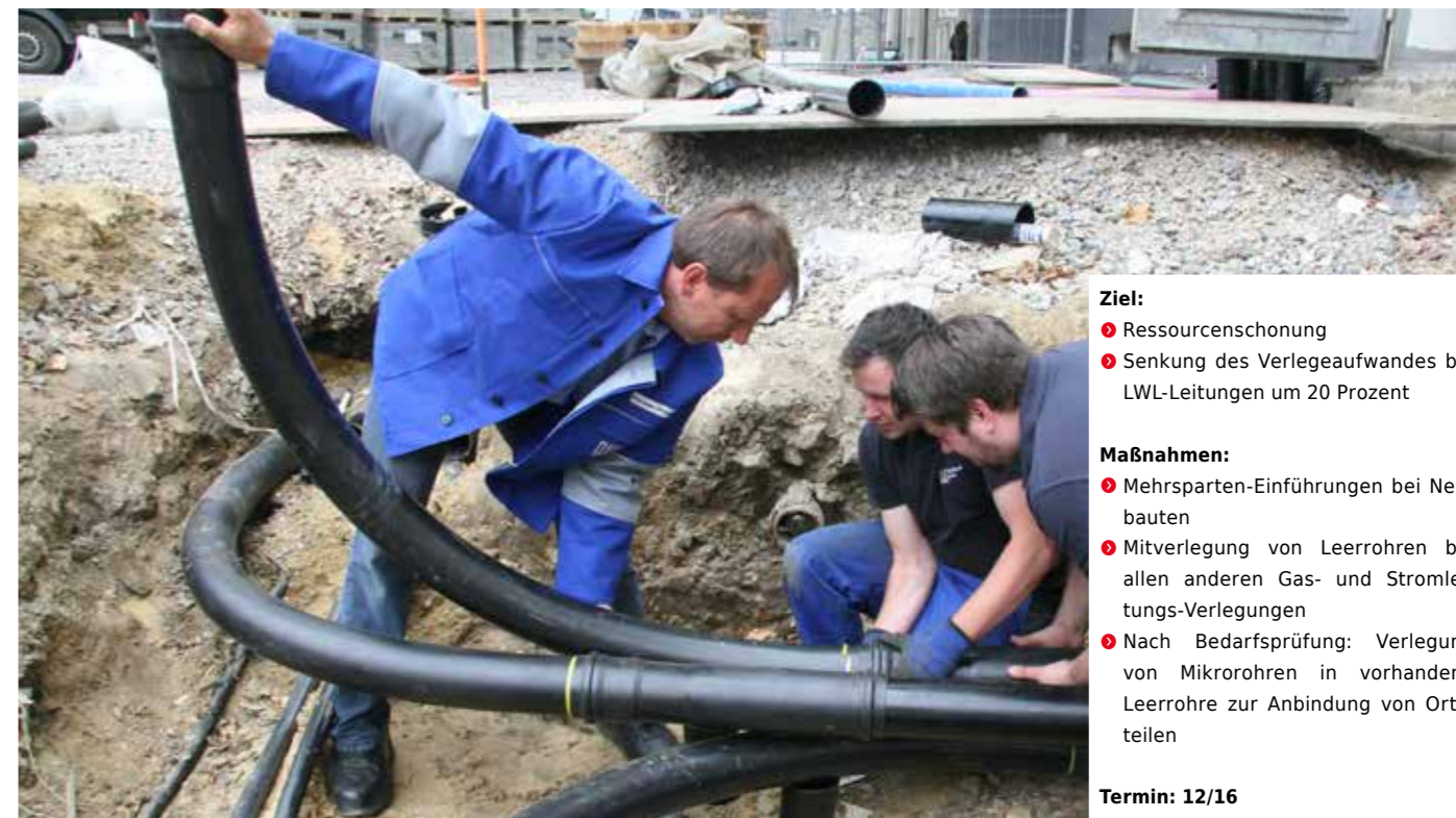
Optimierte Verlegetechnik: In vorhandene Leerrohre werden Bündel von Mikrorohren für Lichtwellenleiter eingezogen.
