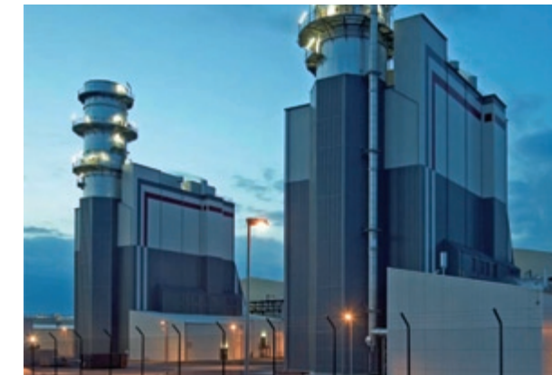
Gas- und Dampfturbinenkraftwerk in Hamm-Uentrop
