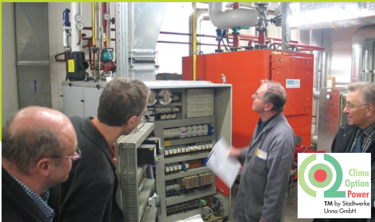
Kleine Blockheizkraftwerke wie etwa hier im Hotel Katharinenhof können für viele Kunden eine Alternative zur Heizung sein.
