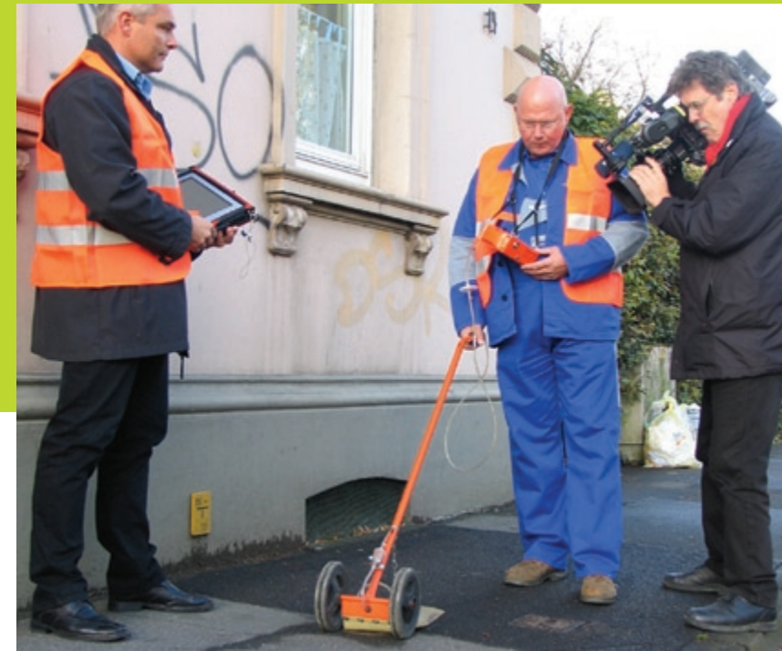
Regelmäßig überprüfen wir alle Gasleitungen auf mögliche Leckstellen. Ortsnetzstationen werden kontinuierlich erneuert.
