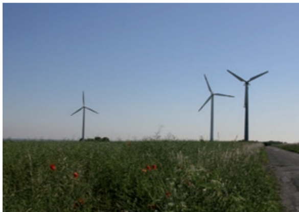
Windkraftwerke auf dem Ostenberg
