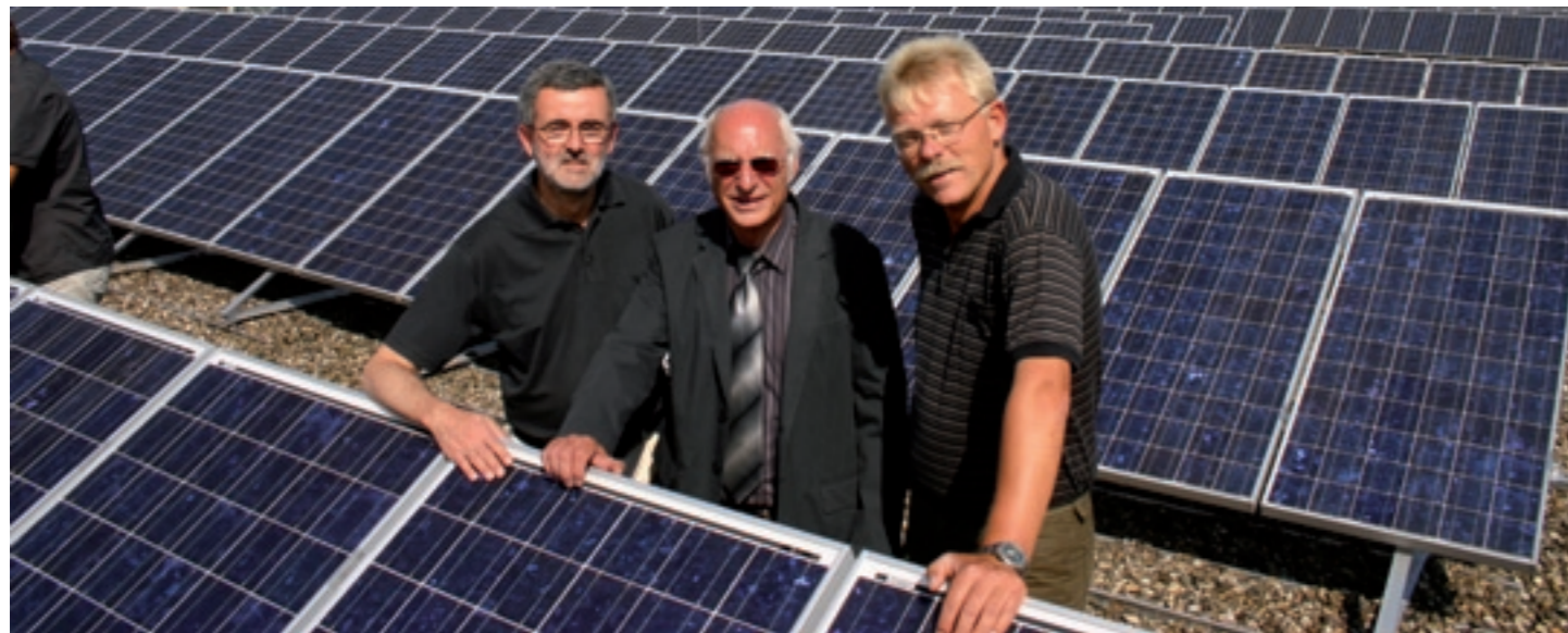
Photovoltaik-Anlage auf dem Schulzentrum Königsborn, v.l.n.r.: Michael Strobel, Leiter des Geschwister-Scholl-Gymnasiums, Prof. Dr. Christian Jänig, Geschäftsführer der Stadtwerke Unna, Hans Ruthmann, Leiter der Gesamtschule Königsborn.
