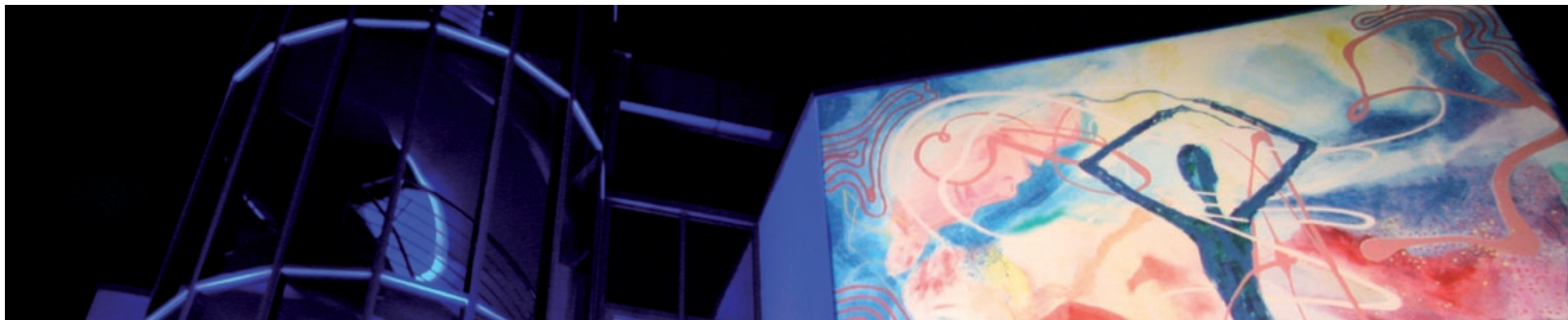
LED-Beleuchtung am Gebäude der Stadtwerke Unna GmbH.
