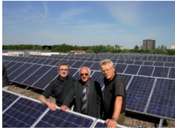
Photovoltaik-Anlage auf dem Schulzentrum Königsborn.
