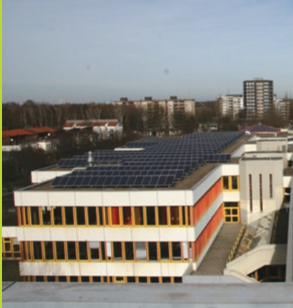
Photovoltaik-Anlage Schulzentrum Königsborn
