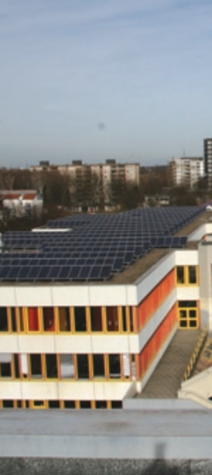
Photovoltaik-Anlage Schulzentrum Königsborn
